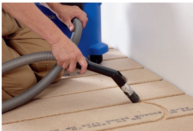
Figur 8 Omhyggelig rengøring forhindrer knirkelyde.
