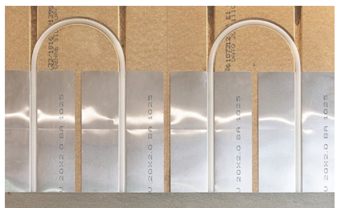
Figur 3 Varmefordelingsplader specielt udviklet til 38 mm Klimagulv.
